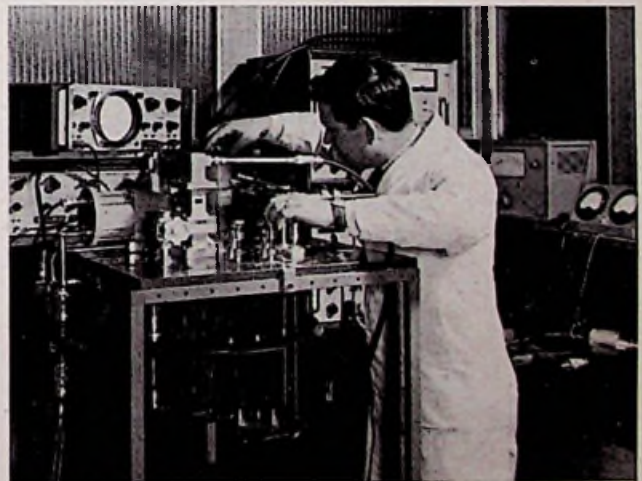
Fig. 8 - Afregeling van de parametrische versterker, zoals in gebruik op Goonhilly (Engeland).
